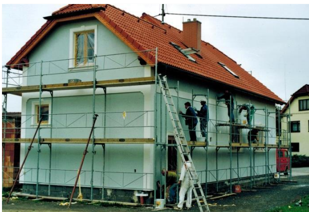
Abb. 1: Auftragen der Fassade
